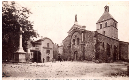
L'église après restauration (1934). Archives départementales de l'Ardèche, collection Dürrenmatt, 79 Fi 1261.
