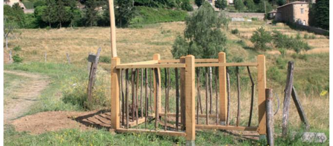
Construction de passe-clôture en châtaigner pour permettre la traversée du pré des vaches, nivellement du chemin et fabrication d'une fresque en mosaïque dans le bassin.
