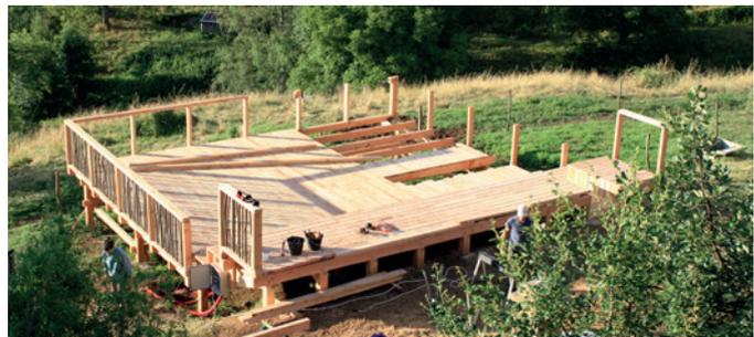
Construction d'une plateforme et gradin en bois de 100 m<sup>2</sup> et installation d'une signalétique métal pour indiquer les entrées du jardin
