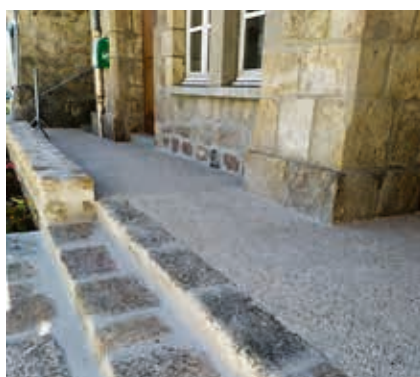
Rampe d'accès mairie et salle des aînés
