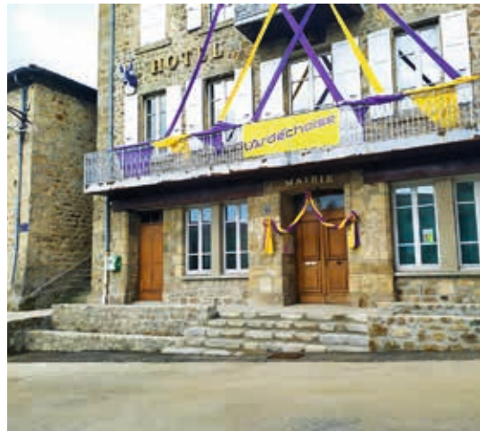
Accessibilité de la salle des aînés et de la mairie
